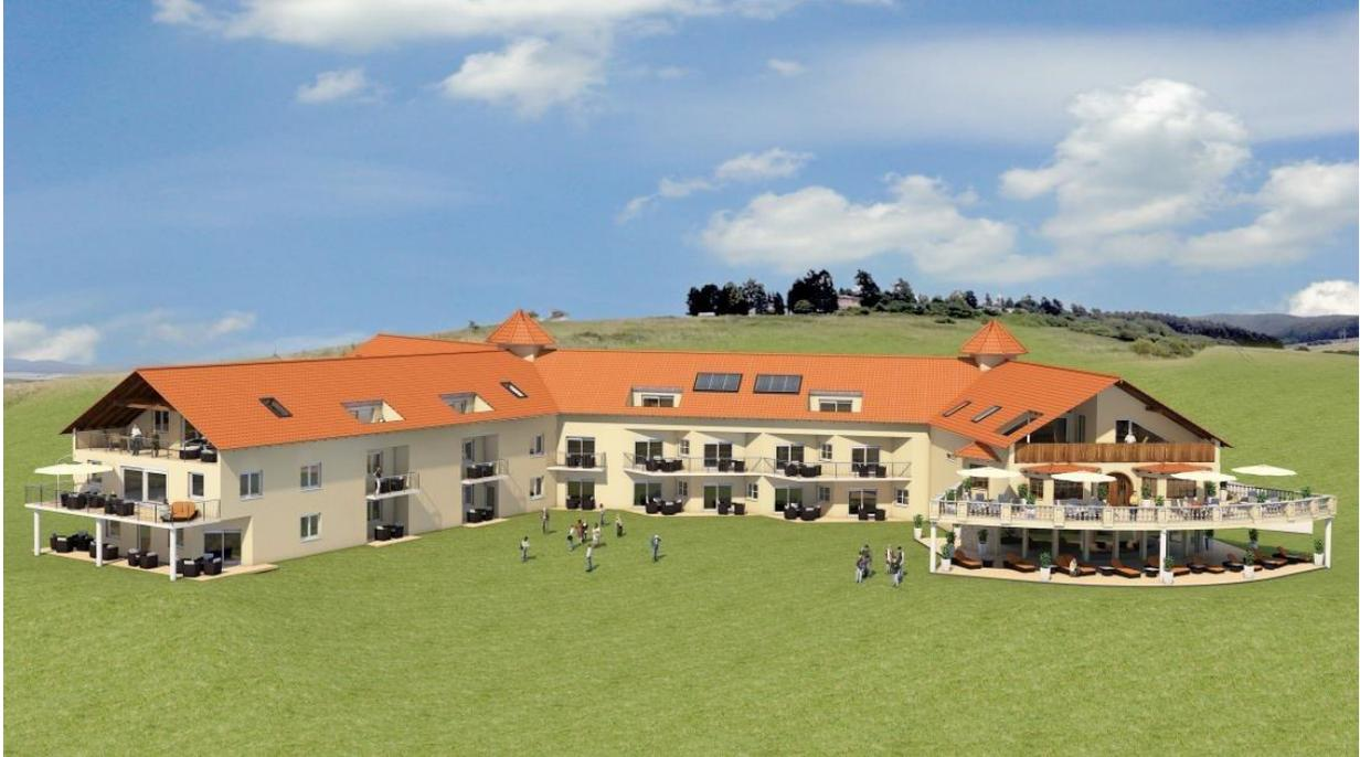
Geplant ist ein dreigeschossiger, barrierefreier Wohnkomplex in regional angepasster Bauweise (Mauerwerk Planziegel W75 oder Porenbetonmauerwerk mit aufgesetztem Fachwerk) als KfW-Effizienzhaus 55 (= hohe Energieeffizienz).
