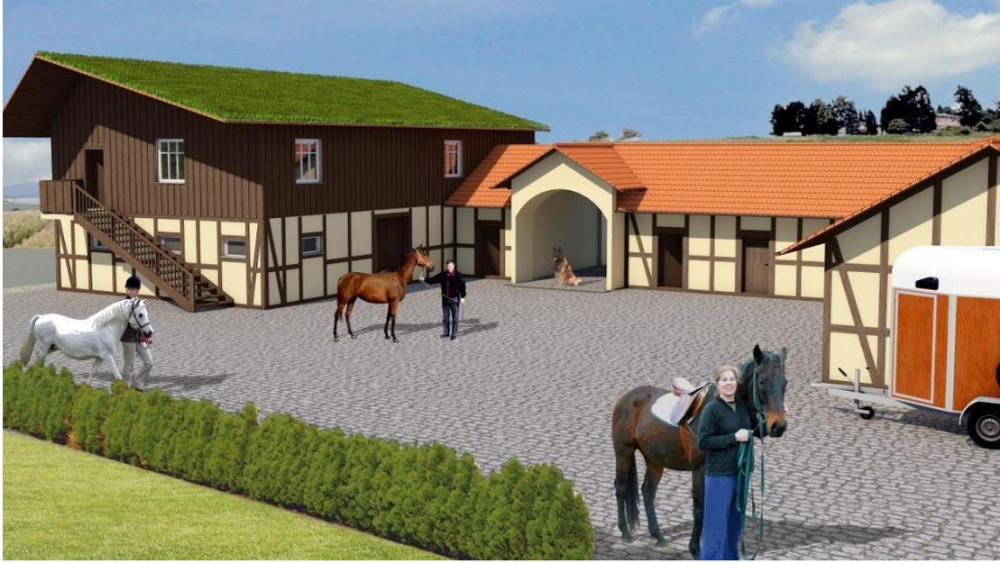
Geplant ist ein Wohnhaus mit Gästezimmerbereich für Feriengäste in massiver Bauweise (Mauerwerk Planziegel W75 oder Porenbetonmauerwerk) mit einer vorgesetzten Holzkonstruktion als Fachwerkfassade sowie einer äußeren Holzbeplankung, Stülpschalung im Obergeschoss mit Unterstellmöglichkeiten für Pferde (Hotelgäste/Waldbühne), Schlepper mit Maschinen sowie einer Garage unterhalb der Wohnanlage.
